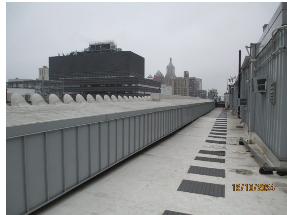
North parapet conduit chase
