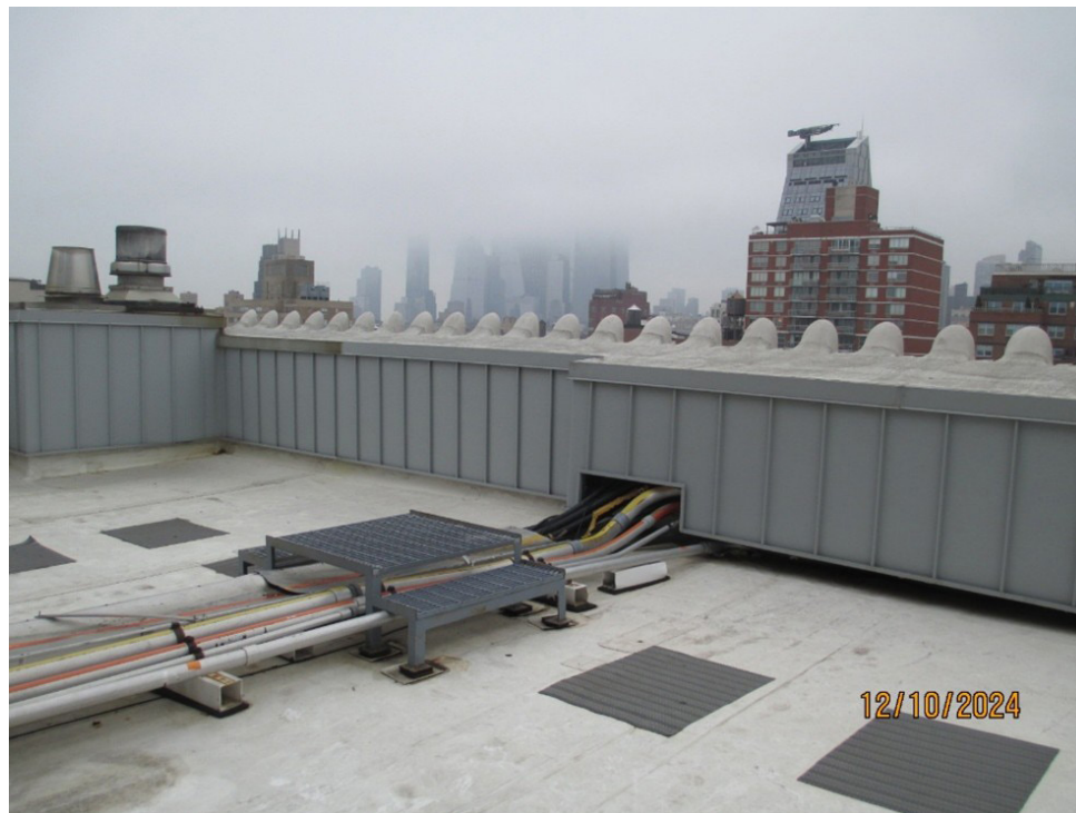
North parapet conduit chase
